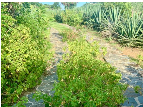
État actuel de la voie
