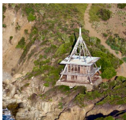
Etat après le cyclone Luis et avant le cyclone Irma
