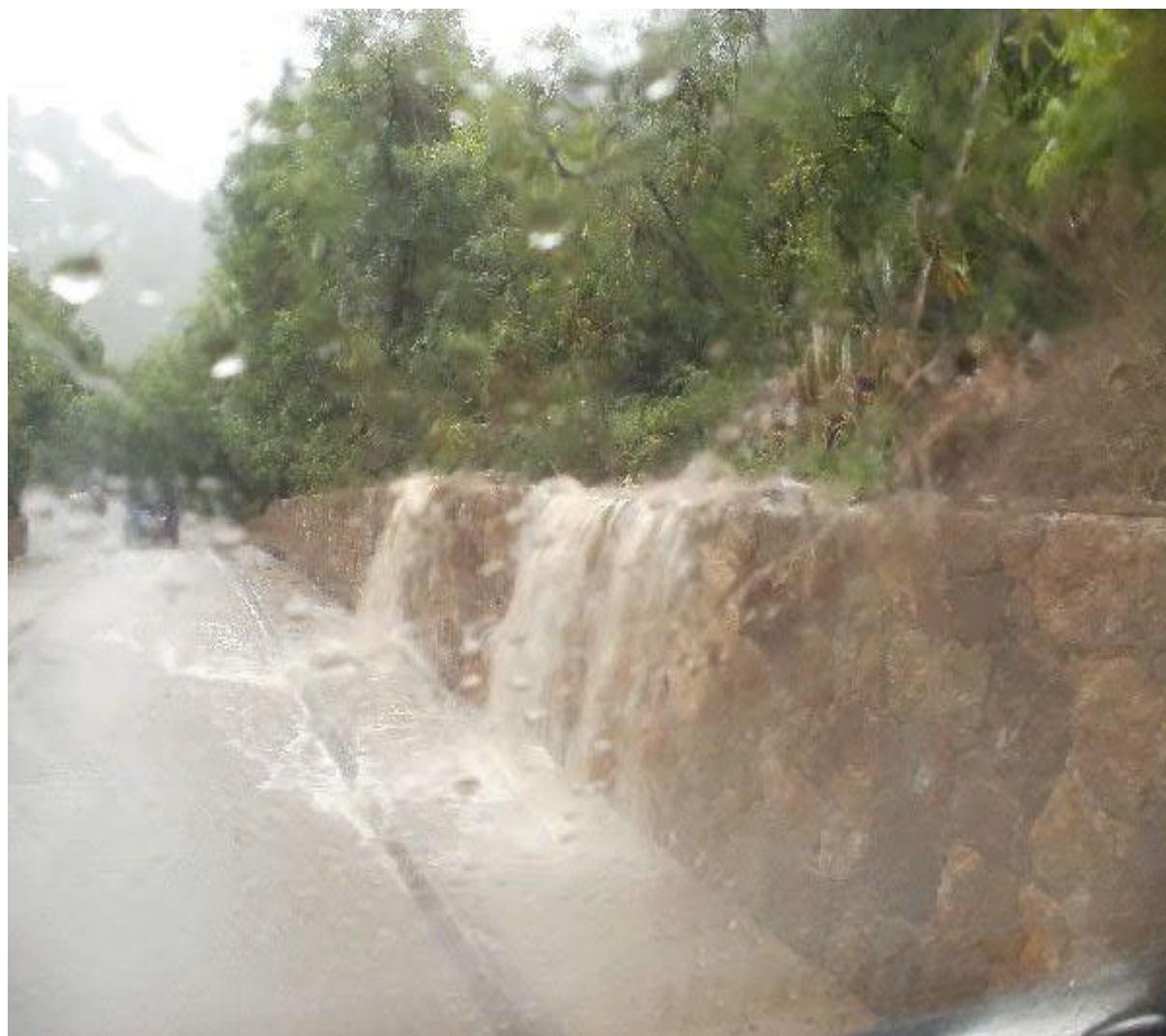
Fortes pluies de 2018 occasionnant des coulées sur la route de petite saline
