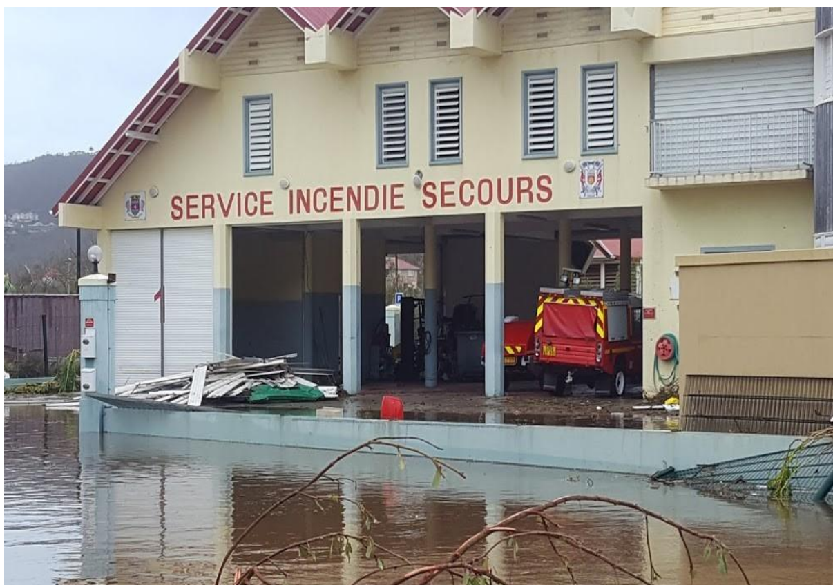
Centre de Secours de Saint-Barthélemy après le passage de l'ouragan IRMA 06/09/2017
