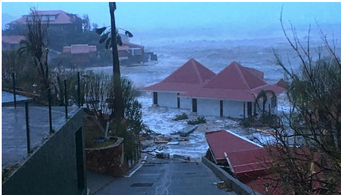
Inondations à Saint Barthélemy secteur plage de Pélican en septembre 2017
