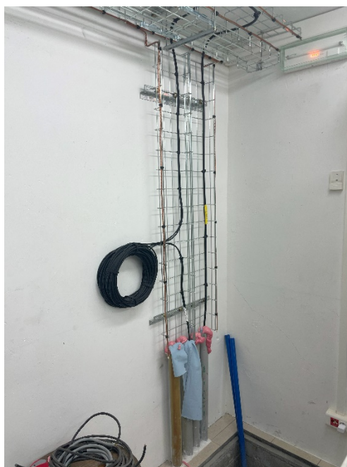
Figure 22 : arrivée du câble GCN
