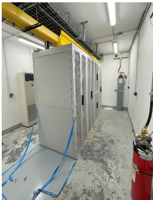
Figure 37 : Allée intérieure en travaux
