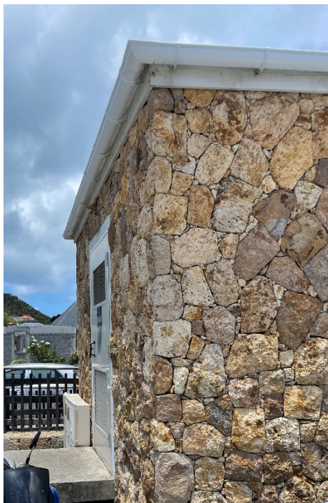
Figure 33 : Poste électrique à proximité du NRO
