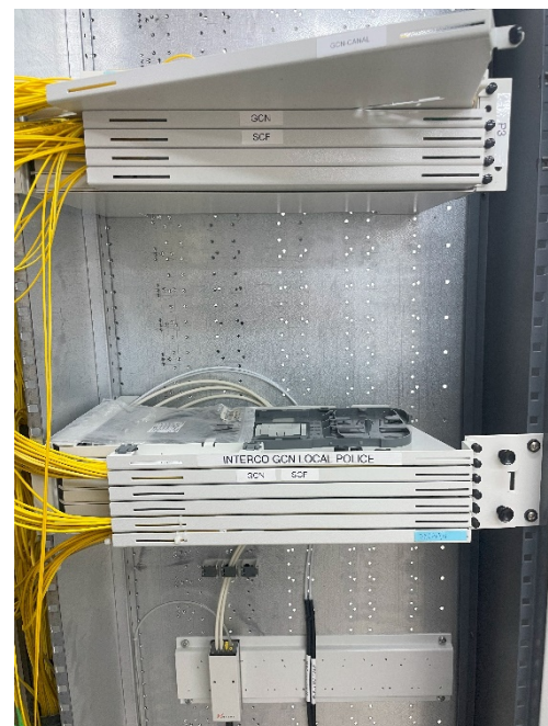
Figure 24 : Connexion du câble GCN au local Police
