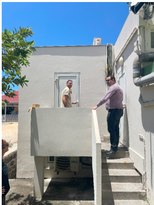
Figure 26 : Local Police - Vue extérieure
