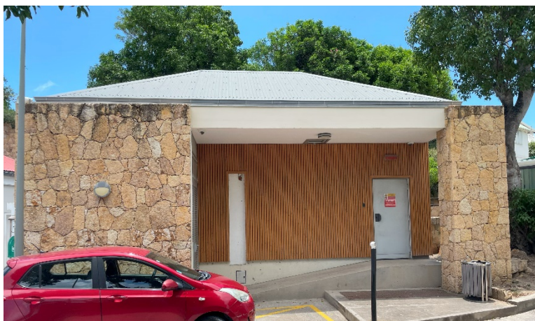
Figure 31 : NRO Lorient - Vue de l'extérieur
